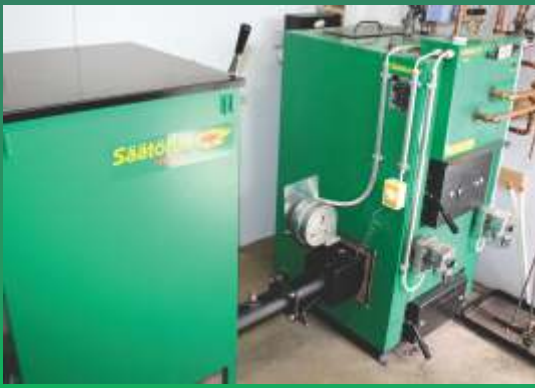
Säätotuli STRONG bioburner connected to a Säätotuli boiler
